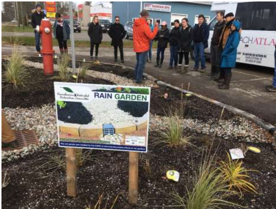
Photo 3: Le jardin de pluie du KWRC à Sussex aide à retenir des eaux de pluie, à la filtrer et la retourner lentement au sol.
